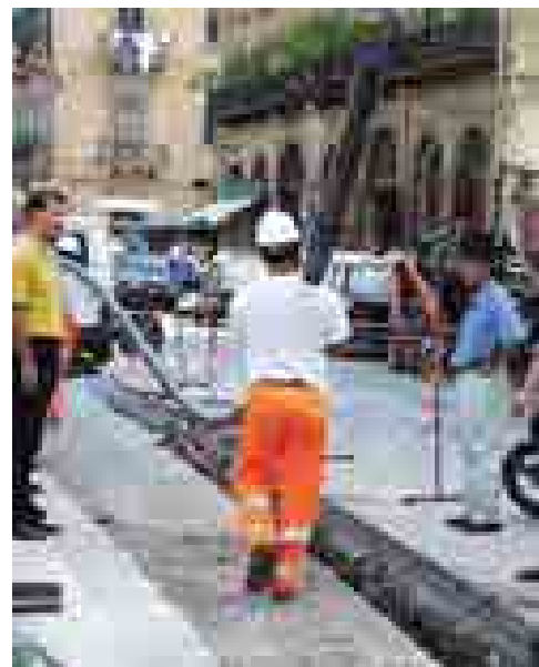
Narrow Trenching using PE pipes
